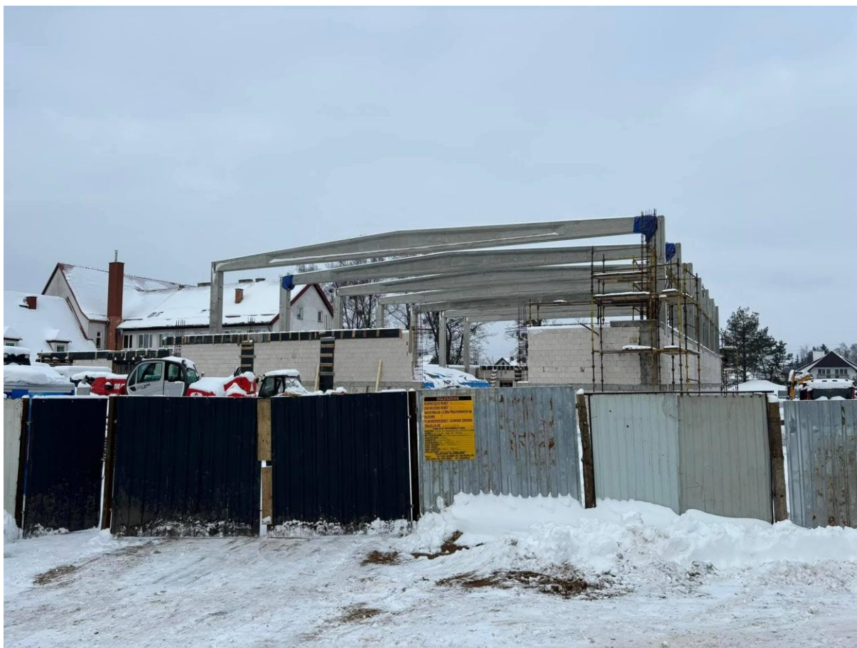
Fot. Budowa Sali gimnastycznej
