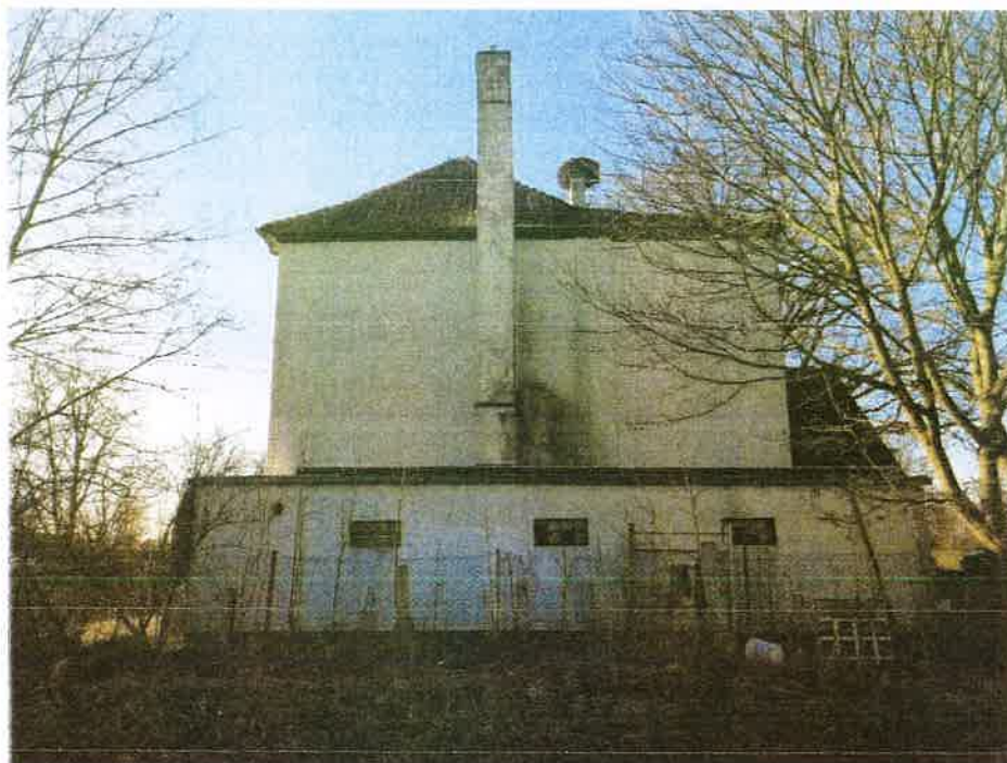
Rys. 3 WIDOK OD STRONY WSCHODNIEJ
