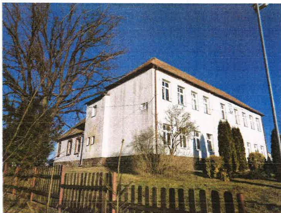
Rys. 4 WIDOK OD STRONY ZACHODNIEJ
