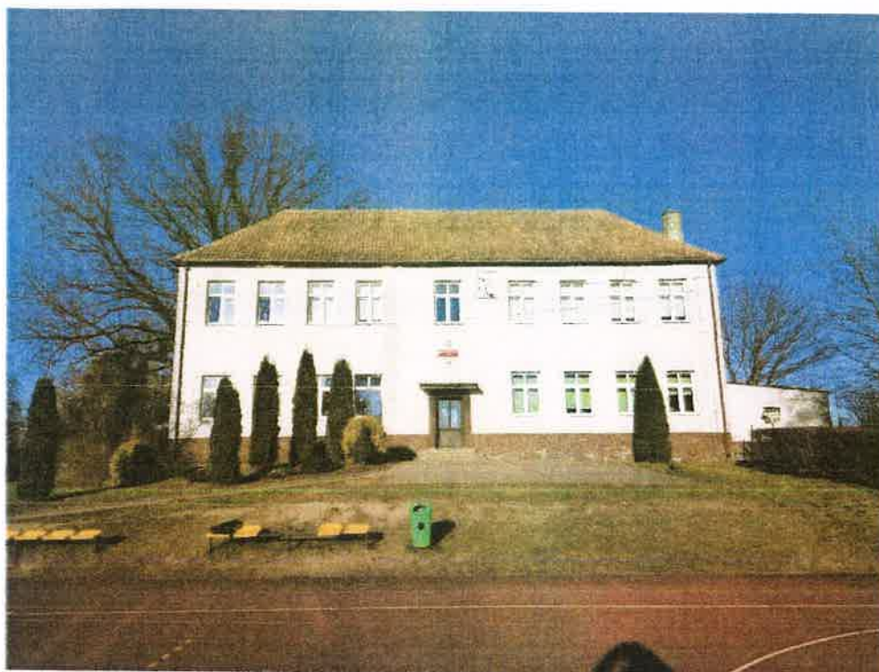
Rys. 1 WIDOK OD STRONY POŁUDNIOWEJ
